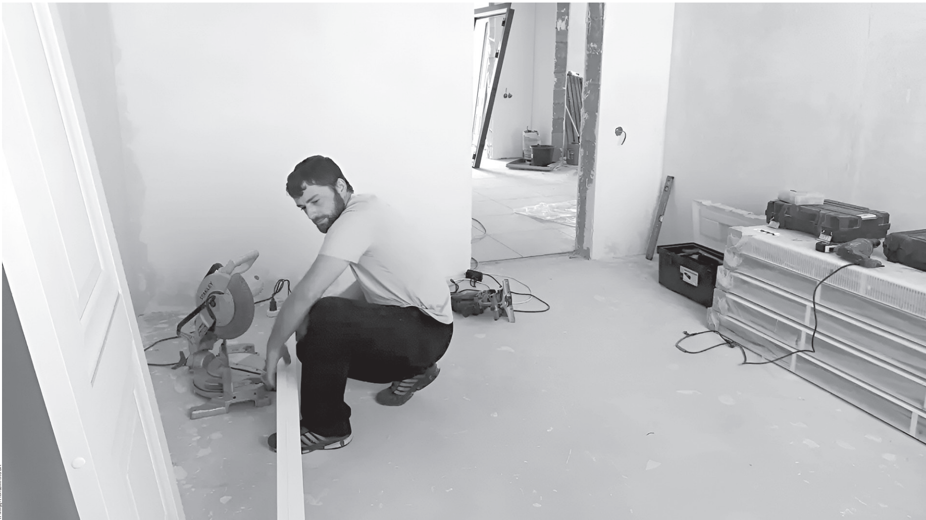
Сейчас в новом доме ведётся установка межкомнатных дверей
